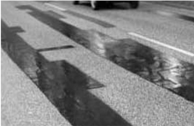
Obwohl in den Merkblättern für die Erhaltung von Asphaltstraße empfohlen wird, Bitumen nur für Reparaturen lokaler begrenzter Schäden (d.h. Nahtschäden, Rissen und Fugen) zu nutzen, wird reines Bitumen häufig auch für großflächige Ausbesserungsarbeiten verwendet.
