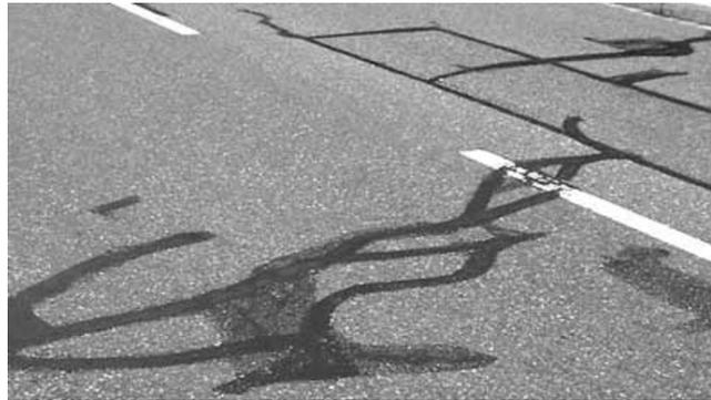
Bei unsachgemäßen Bitumenreparaturen wird häufig auch netzartig gepfuscht und dicke Bitumenwürste quellen aus unsachgemäß versiegelten Straßen.
